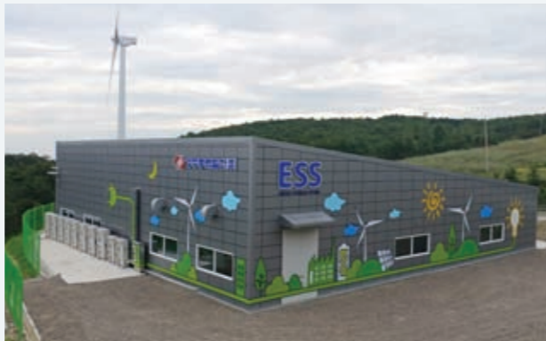
경주풍력 PCS : 3MW / 배터리 : 19MWh 주파수 조정용
