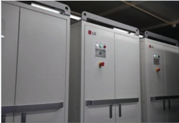
마산대학교 (창원) PCS : 1MW / 배터리 : 2MWh 부하 이동용
