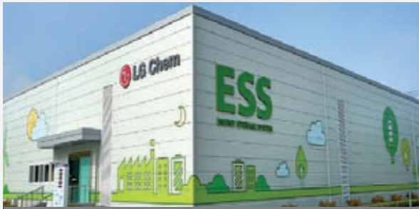
LG 화학 (익산) PCS : 3MW / 배터리 : 23MWh 부하 이동용
